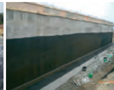
Perde duvarı yalıtımında KÖSTER Deuxan 2K uygulaması
