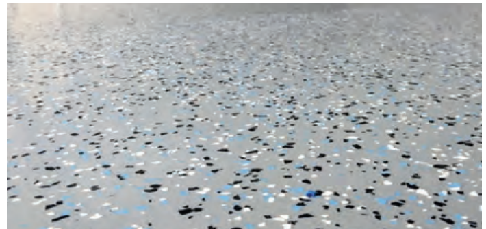
Epoksi çip uygulamasından bir örnek Epoxy chip application
