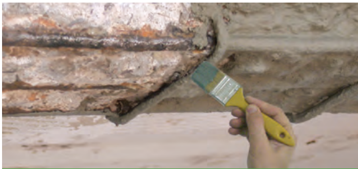
Adex harcı fırça ile uygulanır - Apply Adex with a brush
