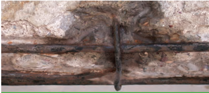
Zayıf beton ve korozyon tabakası temizlenir Clean loose concrete particles and corrosion layer
