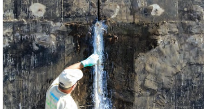
Trabzon Akçaabat Belediyesi İçme Suyu Deposu
