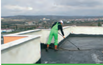
Teras Yalıtımı Terrace waterproofing
