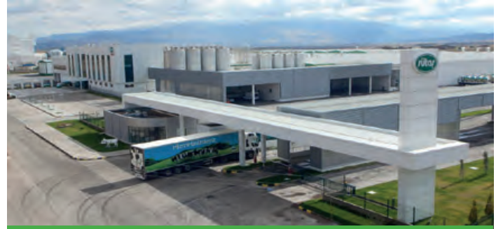
Bursa Süttaş Arıtma Tesisi
