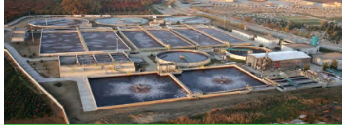
Bursa Gürsu Arıtma Tesisi
