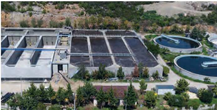
Alanya Konaklı Belediyesi Arıtma Tesisi
