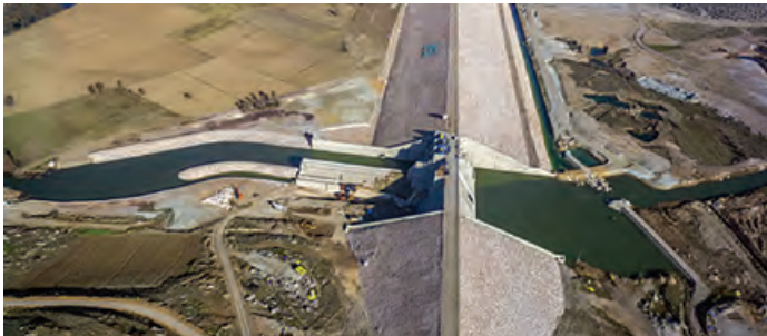
Kayseri Gümüşören HES Projesi
