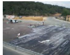
Yol aydınlatmasında KÖSTER Deuxan 2K ile yalıtım uygulaması
