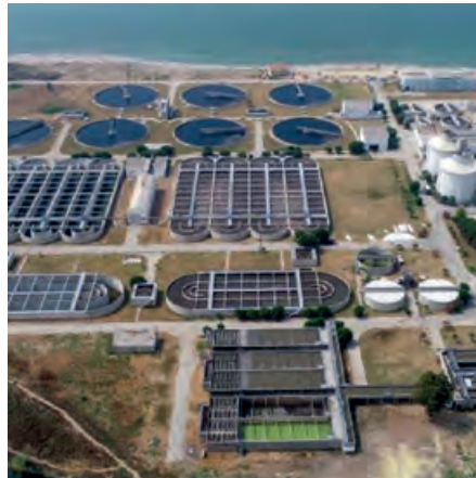
Karaduvar Atıksu Arıtma Tesisi, Mersin
