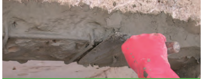
Repamor yapısal tamir harcı uygulanır - Apply Repamor repair mortar
